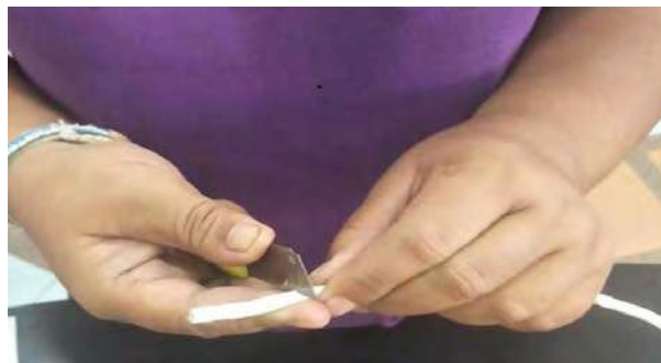
รูปที่ 1.2.1 นำคัตเตอร์ปลอกเปลือกนอกของสายแลน Cat 5e
