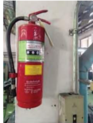
รูปที่ 1.10 การติดตั้งอุปกรณ์ดับเพลิง
