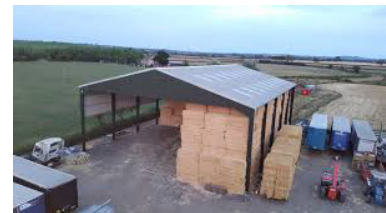
รูปที่ 1.16 การเตรียมวัสดุและอุปกรณ์ในการซ่อมแซมฟาร์ม (ที่มา : https://image.made-in-china.com )
