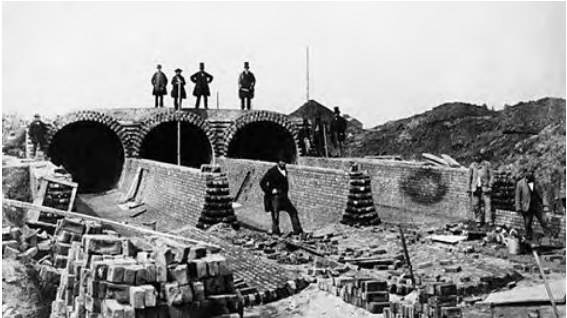
ภาพที่ 1.2 ระบบบำบัดน้ำเสียในเมืองลอนดอน (ที่มา: BBC, ม.ป.ป.)
