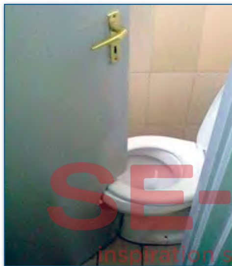
รูปที่ 1.6 การวางตำแหน่งสุขภัณฑ์ที่ไม่ถูกต้อง
