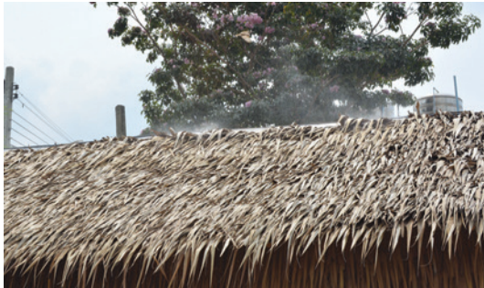
ติดสปริงเกลอร์ช่วยปรับอุณหภูมิจากหลังคานอกโรงเรียน
